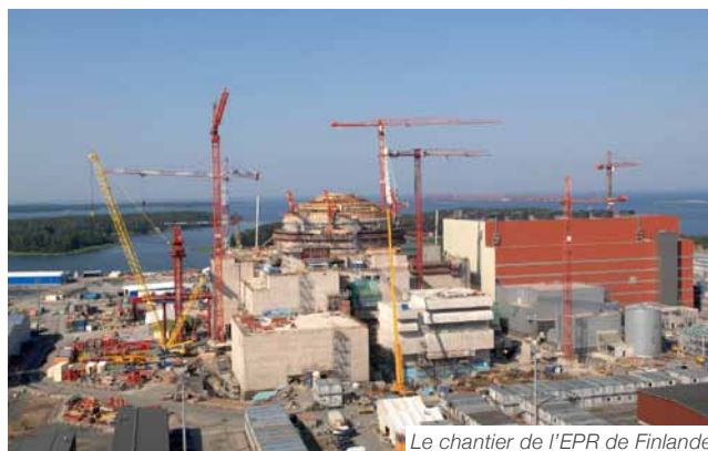
Le chantier de l'EPR de Finlande
